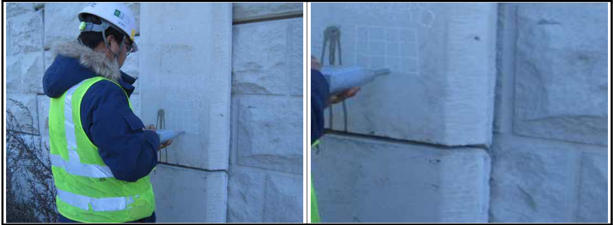
【그림 8.3.6】 슈미트해머를 이용한 반발경도시험 전경
